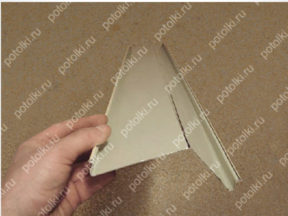
5. Потолочную рейку отрезаем точно по отмеренному расстоянию и отрезаем лишнее ножницами по металлу либо строительным ножом
