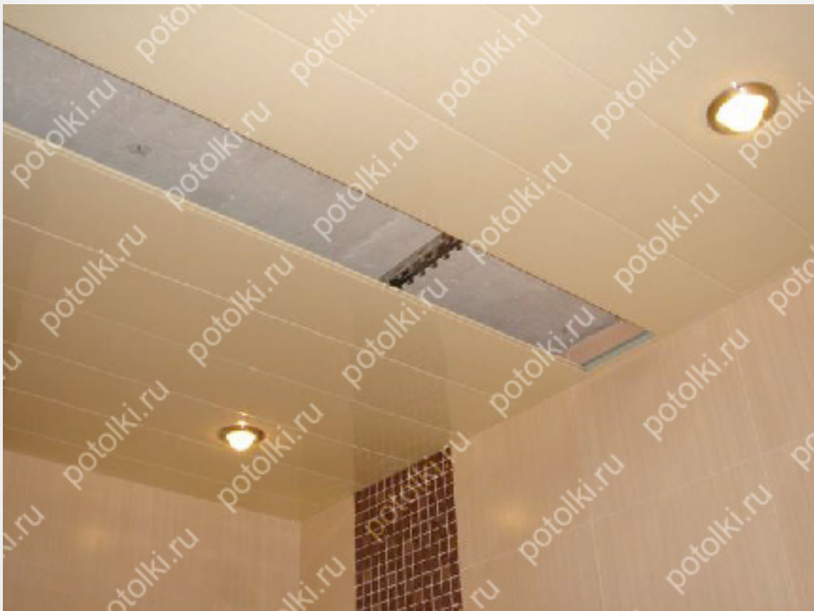
13. Собираем в сторону центра оставшиеся реечные панели. Параллельно подсоединяем кабель питания к светильникам и подключаем светильники
