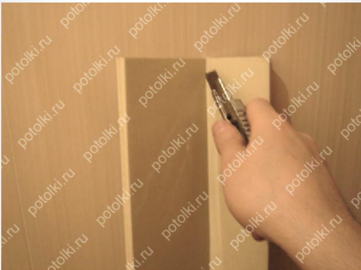
7. Рейку подрезаем с обеих сторон, с лицевой стороны защитную плёнку, с внутренней стороны алюминиевую поверхность
