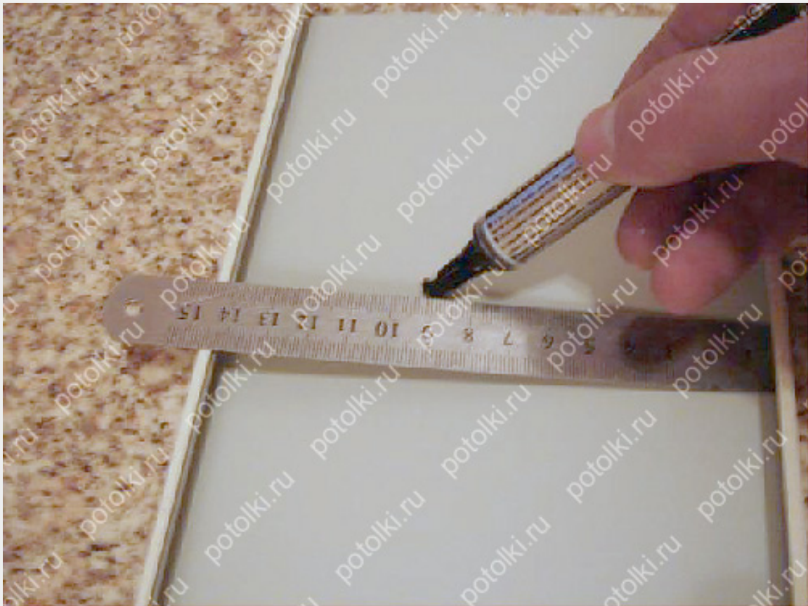
6. Крайние к стенам потолочные панели разрезаем ножом вдоль длины рейки
